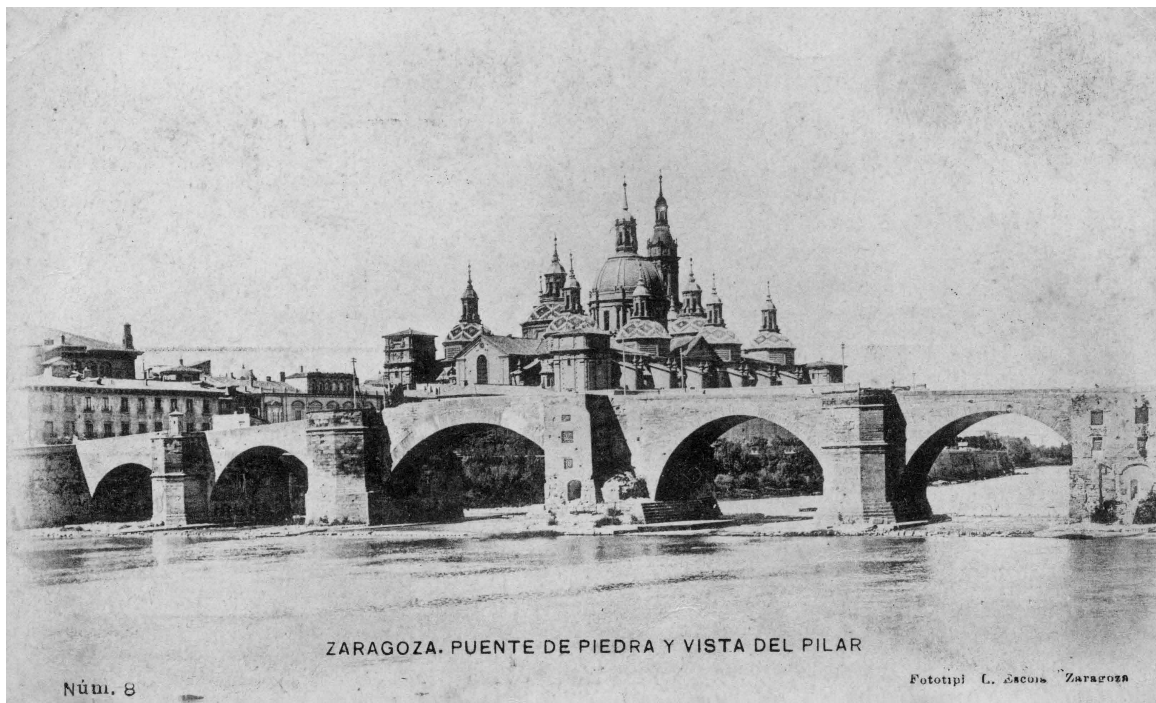
Puente de Piedra y vista del Pilar. Archivo Municipal de Zaragoza, 4-1_07813.
