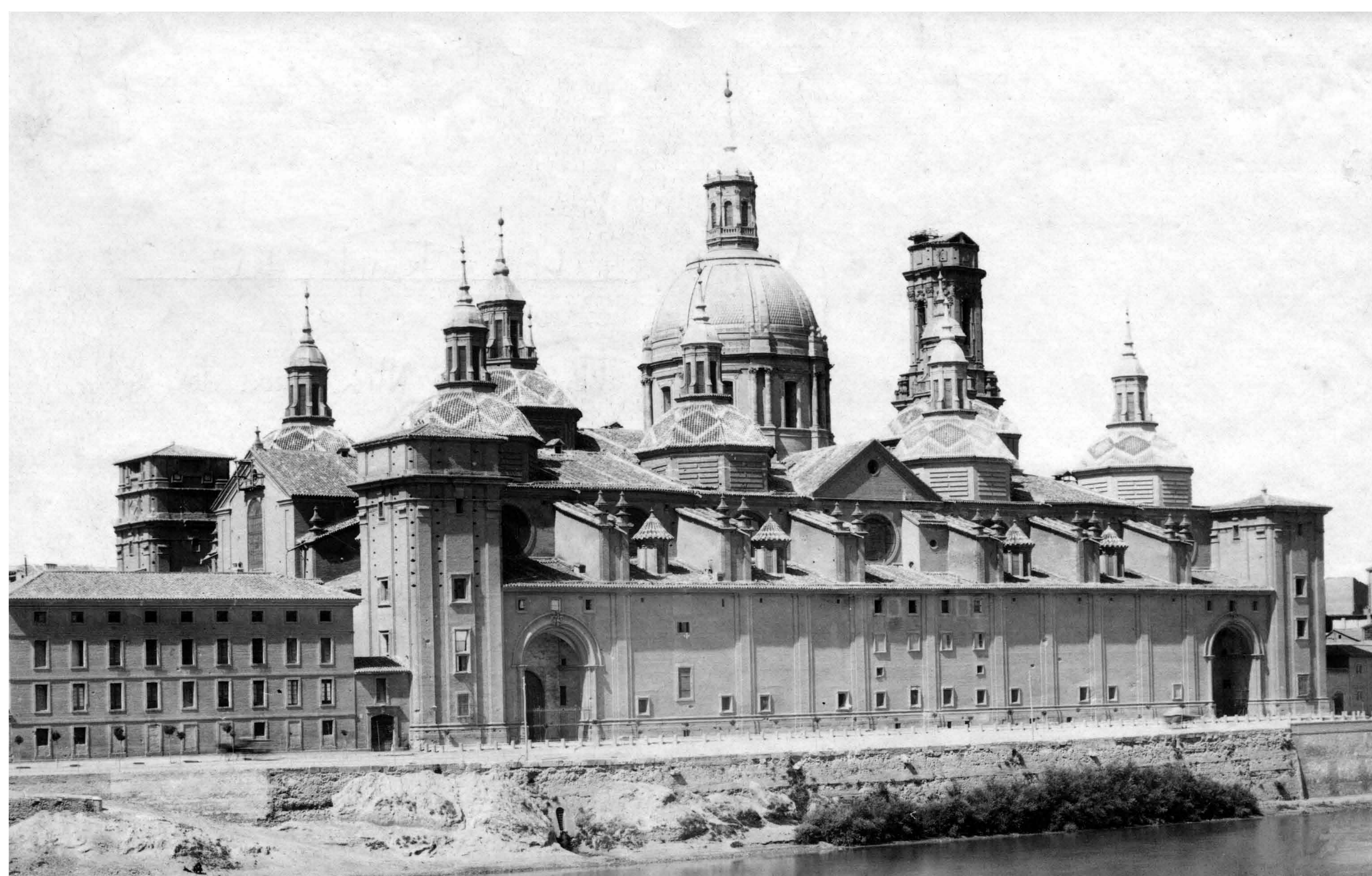
Vue extérieure du temple El Pilar, depuis la rive gauche de l'Ebre. Charles Clifford. Vers 1860. Archivo Municipal de Zaragoza, 4-1 01067.
